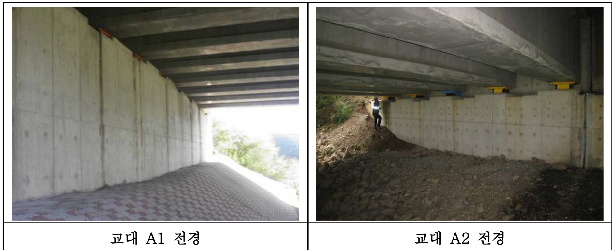
【사진 16.3.8】 교대 전경
