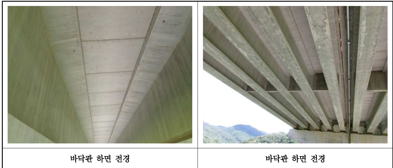
【사진 16.3.2】 바닥판하면 전경
