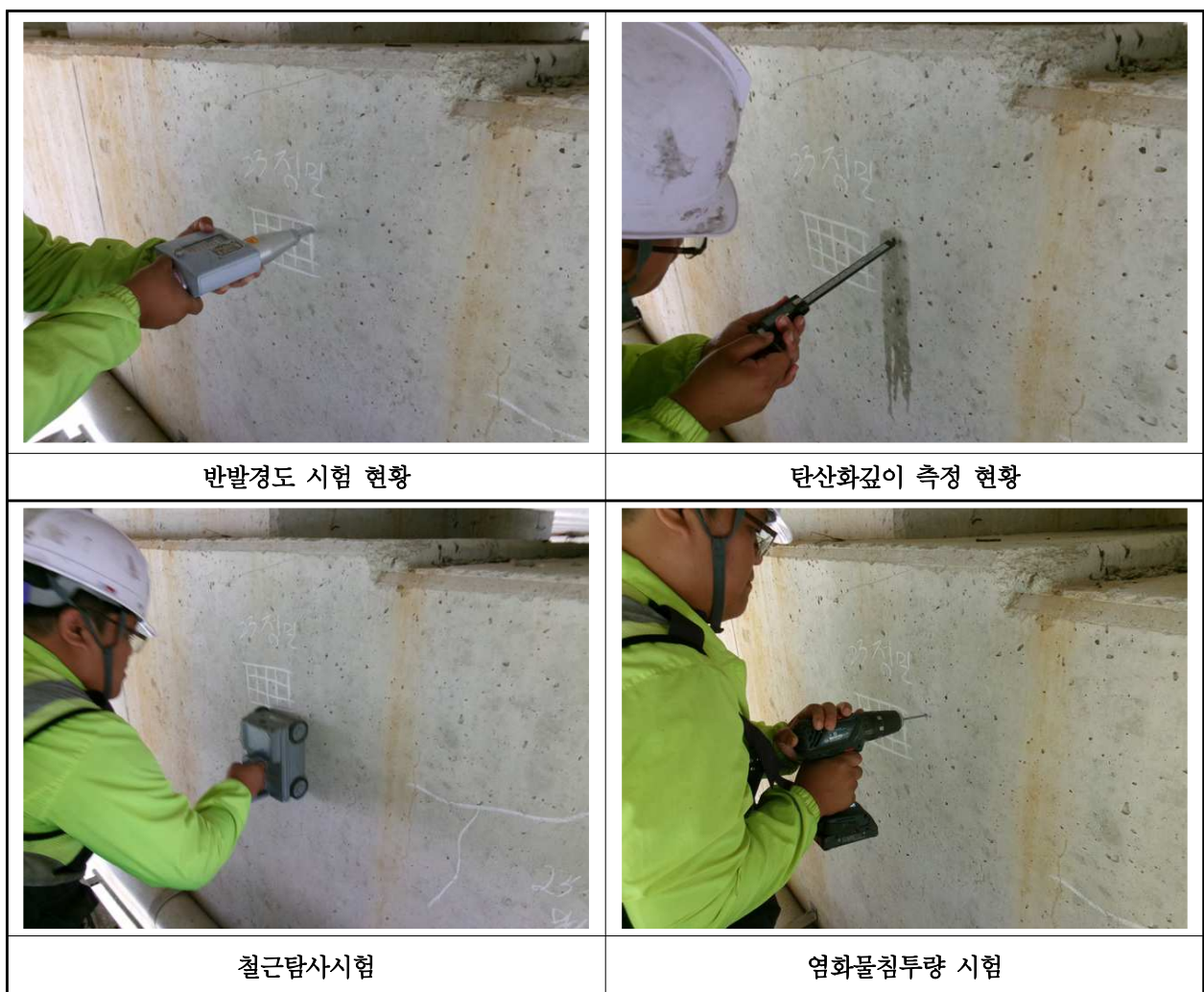
【사진 16.4.1】 콘크리트 내구성조사 현황
