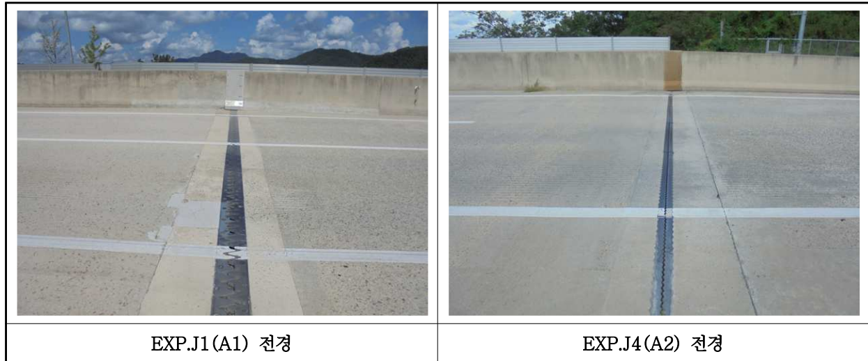
【사진 16.3.41】 신축이음장치 전경
