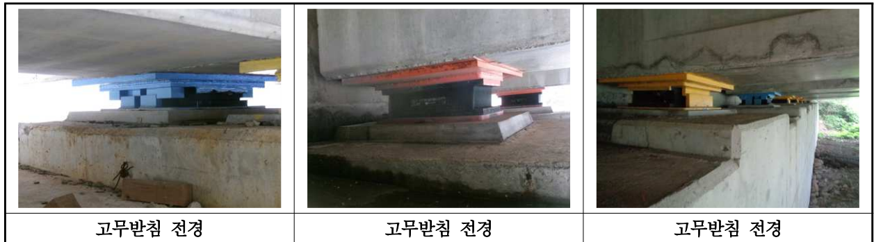
【사진 16.3.12】 교량받침 전경
