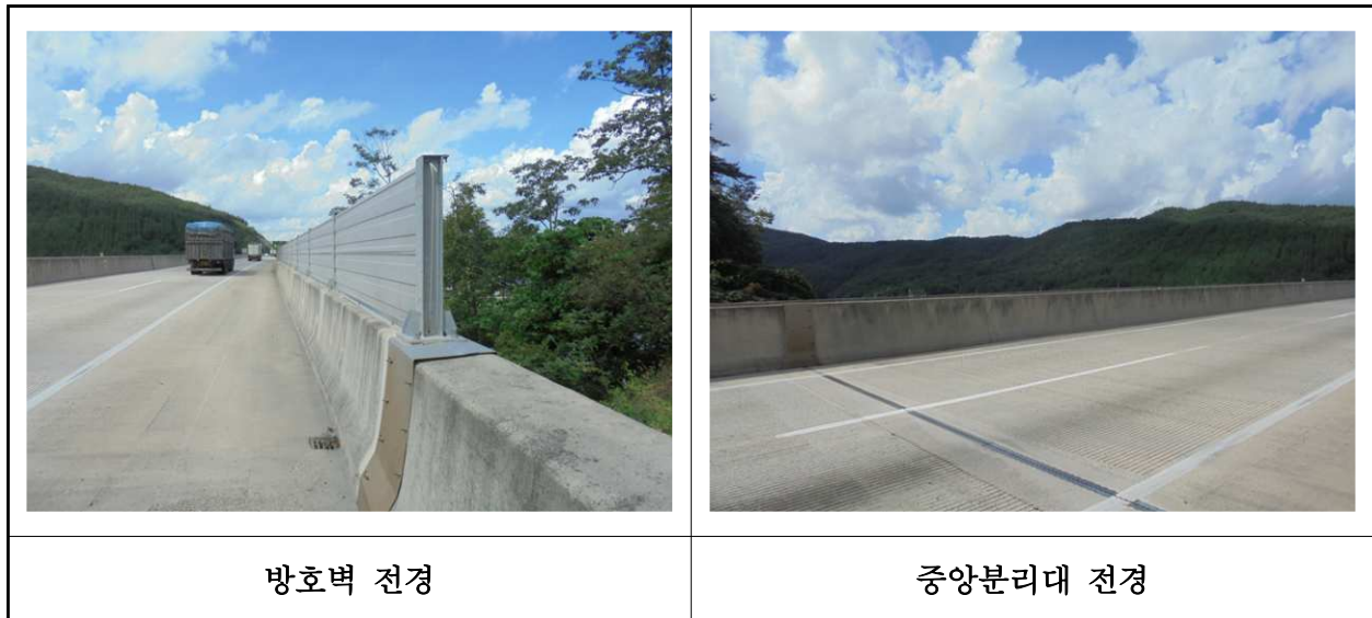
【사진 16.3.23】 방호벽 및 중앙분리대 전경
