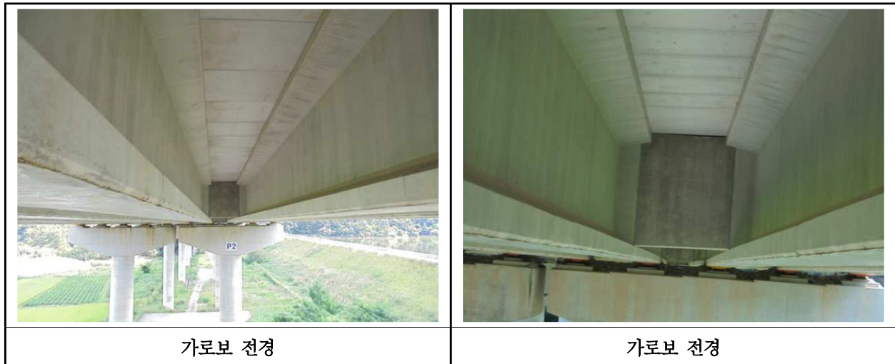
【사진 16.3.31】 가로보 전경
