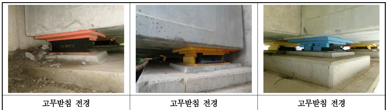
【사진 16.3.37】 교량반침 전경
