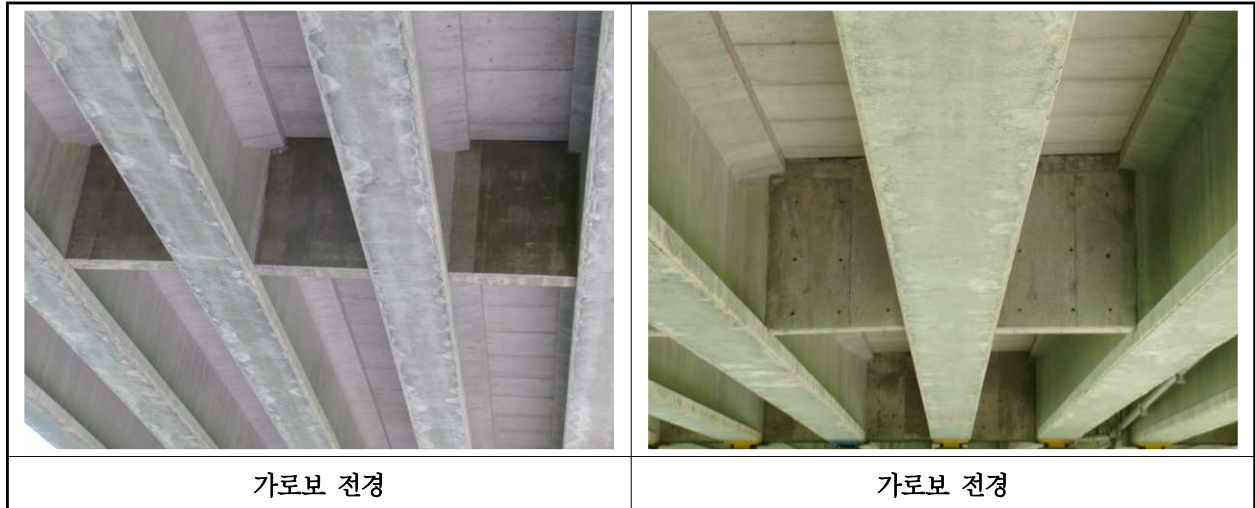
【사진 16.3.6】 가로보 전경
